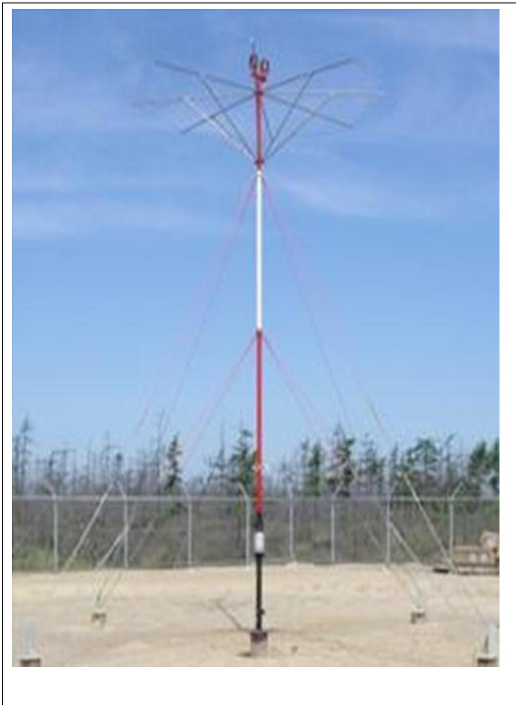
**В радиостанции применяется зонтичная антенна с 16 лучами противовеса по 50 м каждый. Радиостанция может работать на основную антенную сеть (высота мачты 22 м) и на малую антенную сеть (высота мачты 8 м).**
